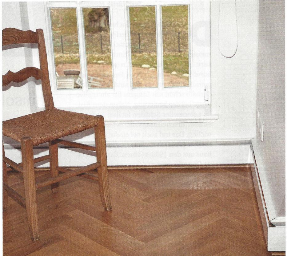
**Aufbau:** Das Sockelheizleisten-Element besteht aus zwei Kupferrohren, auf denen Wärmeleitbleche mit trapezförmigen Lamellen befestigt sind.
