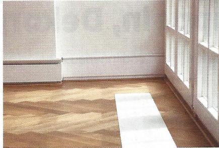
**Optik:** Eine pulverbeschichtete Blende lässt die Heizeinheit verschwinden.
