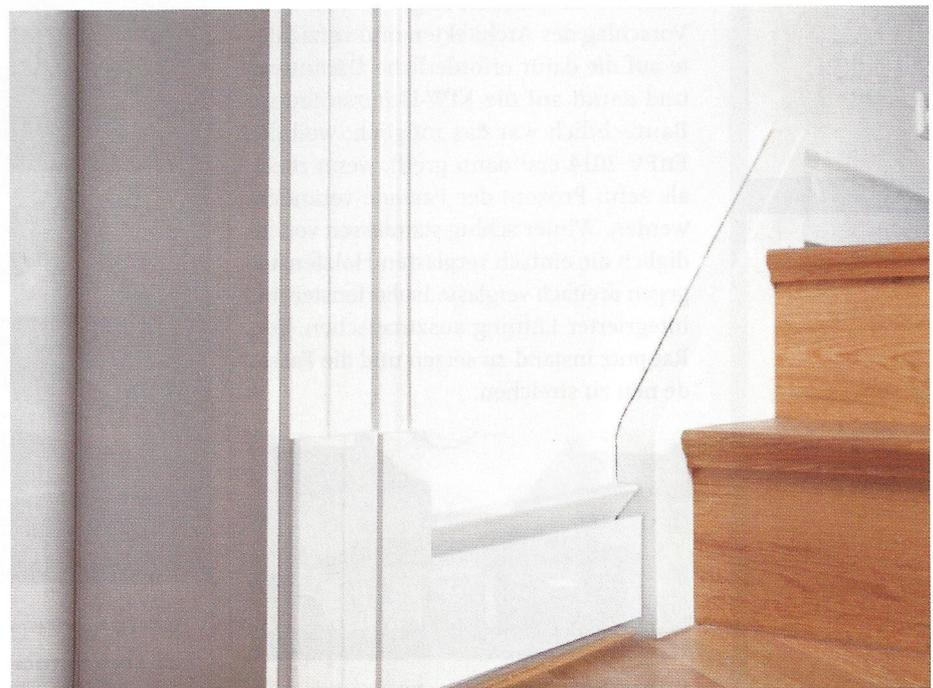
**Funktionsweise:** Die Wärme der wasserführenden Kupferrohre erwärmt die Bleche und überträgt die Wärme auf die darüberliegende Wand.
